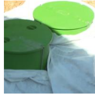
Poser un géotextile sur le gravier
