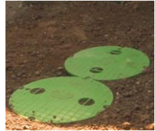
Finir le remblaiement avec de la terre végétale
