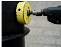
À l'aide d'une scie cloche percer le trou
