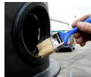
Insérer le joint et lubrifier
