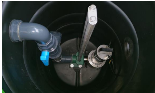
Vanne d'arrêt position vertical modèle sur rail et pied d'assise
