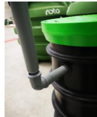
Poussez le tuyau PVC dans le joint
