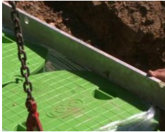
Vérifier que le couvercle est correctement horizontal
